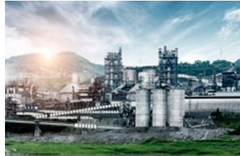
Stavební hmoty přeprava cementu potřebný tlak 4 bar
